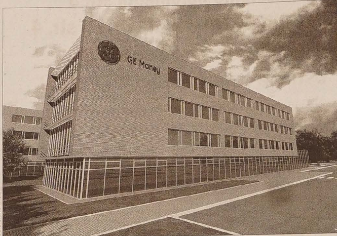
Model Centrum Usługowego GE Money, w którym będzie mieścić się call-centrum do obsługi rynku czeskiego i słowackiego, a którego budowa rozpocznie się w tym miesiącu w Ostrawie Hrabowei.
