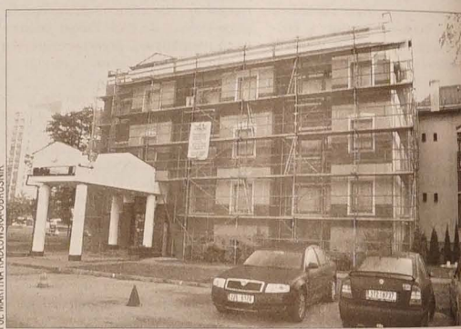
Po 14 latach od oddania do użytkowania (2 maja 1992 r.) Dom Polski w Ostrawie doczekał się nowego tynku. Rozpoczęte w ub. tygodniu prace elewacyjne zaplanowane są do końca października. W tym celu wybudowano nowe budynki na terenie starej części hotelowej. Od wiosny przyszłego roku zaprojektowano także prace fasadowe na starych częściach budowlanych. Jak dowiedzieli się redakcja „GL”, tynki położone zostaną w przyszłości, co były, barwach.
