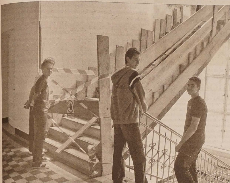
Po tych schodach uczniowie górnośląskiej PSP będą chodzić do nowoczesnych jasnych klas na poddaszu. Pytanie brzmi: kiedy to wreszcie nastąpi?
