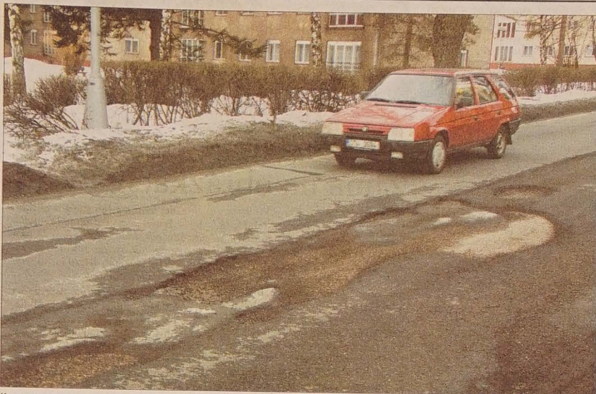
Koszty zimowego utrzymania dróg zwiellokrotniła cena, którą odpowiednie służby będą musiały wydać na naprawę szkód, jakie śnieg i mróz wyrządziły na nawierzchniach jezdni. Dziur w asfalcie jest tyle, że drogowcom będzie trudno je załatać do... następnej zimy. Na zdjęciu: wyloty na ulicy Ostrawskiej w Cz. Cieszynie, drodze wylotowej w stronę Hawierzowa i Ostrawy.
