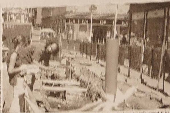
Twa przebudowa centrum Ostrawy. Zanim robotnicy przystąpią do układania nowej infrastruktury wadliwego kanalizacyjnej, na przyszły ich plac budowy weźli archeologów. Na ul. Puchmajerowej, skąd pochodzi złoże, w czasie pogłębianych wykopów poszukiwano śladów cmentarza z czasów plagi dżumy, a także resztek murów obronnych Morawskiej Ostrawy.
