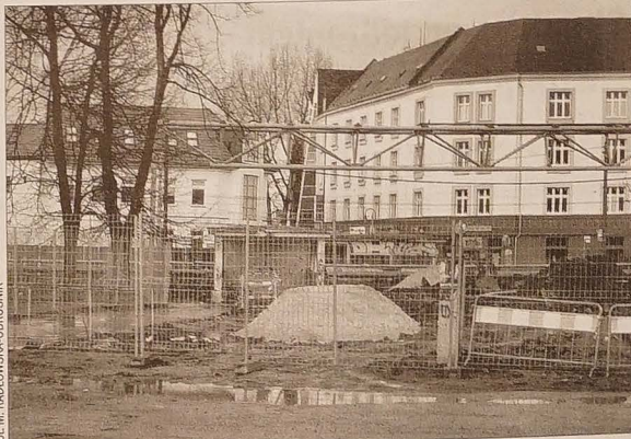
Pomimo kalendarzowej zimy na placu budowy trwają prace ziemne. Na wprost widoczna ulica Stodolní.
