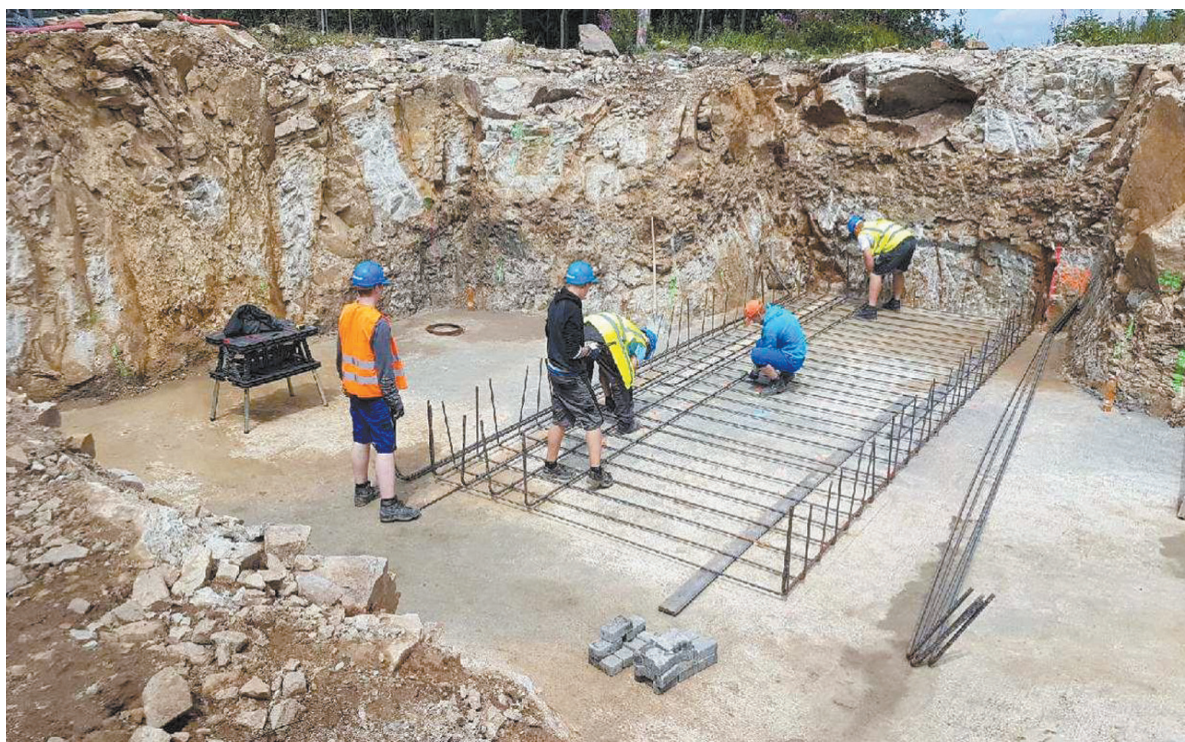
• Trwa budowa górnej stacji kolei linowej na Severce. Fot. RENATA LACKO
