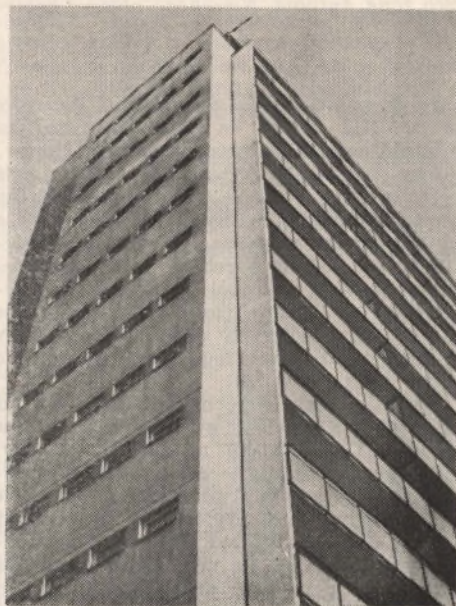
Fragment elewacji wieżowca u zbiegu ulic Tamki i Kopernika w Warszawie.
