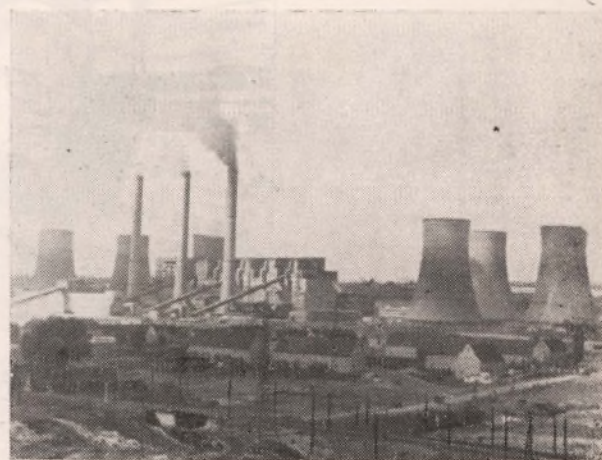
W elektrowni "Turów" na Dolnym Śląsku rozpoczęto prace związane z rozruchem kolejnego, czwartego już bloku energetycznego. Po uruchomieniu tego bloku w grudniu br. "Turów" osiągnie 800 megawatów.
