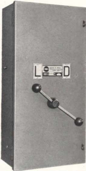
Chave blindada de 30 a 600A, até 600V, de ligamento e desligamento extra-rápido (quick make-quick break) com comando frontal, com travamento da porta.
