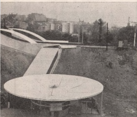
Nowy przystanek linii średnicowej w Warszawie "Powiśle".
