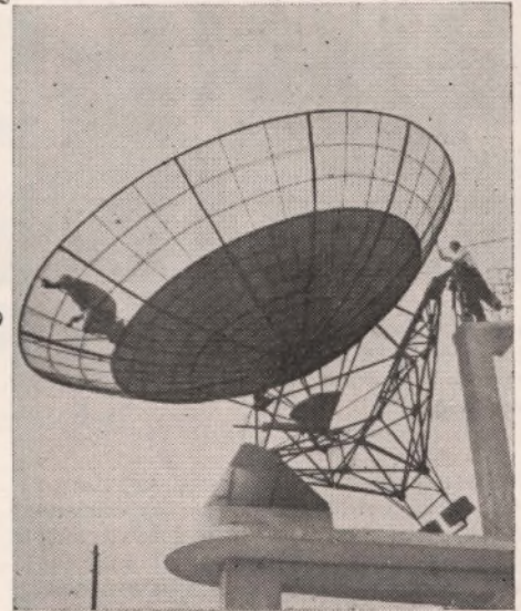
Montaż radioteleskopu w Obserwatorium Astronomicznym Uniwersytetu Jagiellońskiego.
