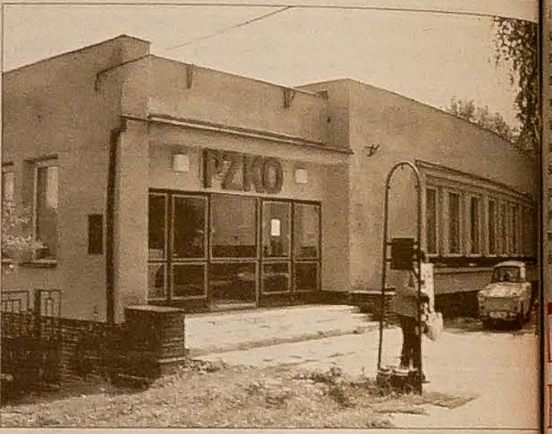
Dom PZKO w Orłowej Lutyni zatracił już swój pierwotny wygląd.
