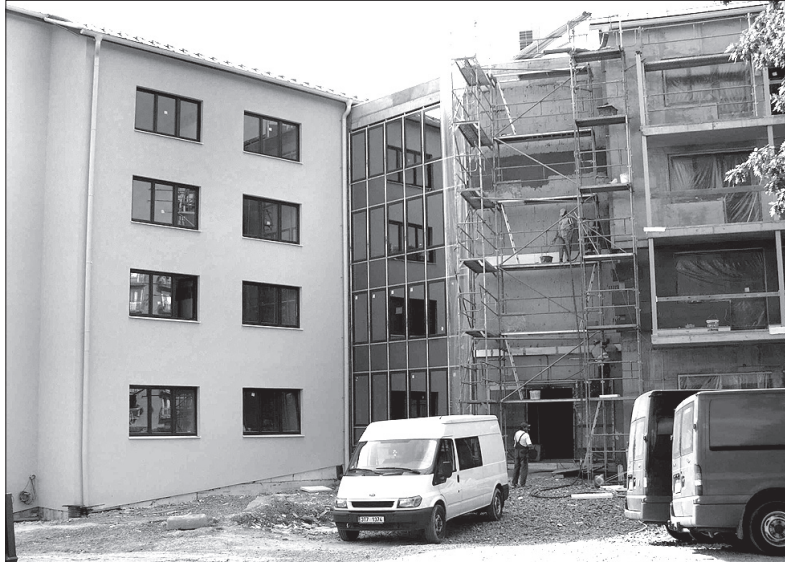
Budowa nowego Domu Seniora w Hawierzowie wkracza w końcową fazę. Już w 1. półroczu przyszłego roku wprowadzą się do niego pierwsi lokatorzy.
