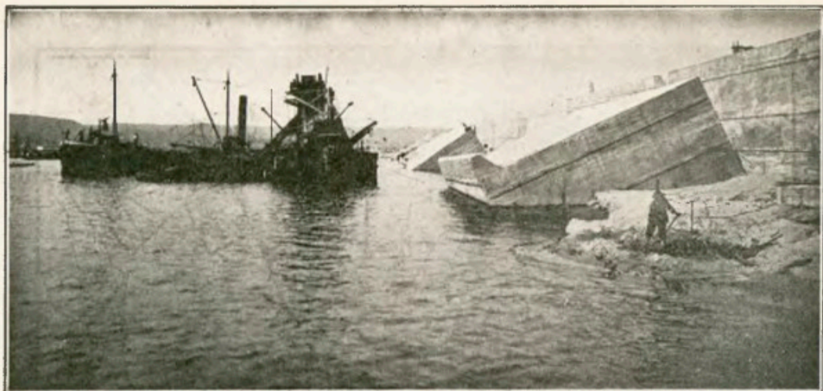
MISE A L'EAU DES CAISSONS DES QUAIS DU PORT DE GDYNIA
