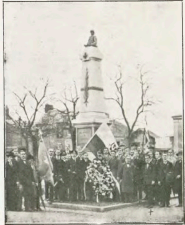
A COUERON (LOIRE-INFÉRIEURE) LES OUVRIERS POLONAIS AU MONUMENT DE NOS MORTS (+ M. JAHAN)
