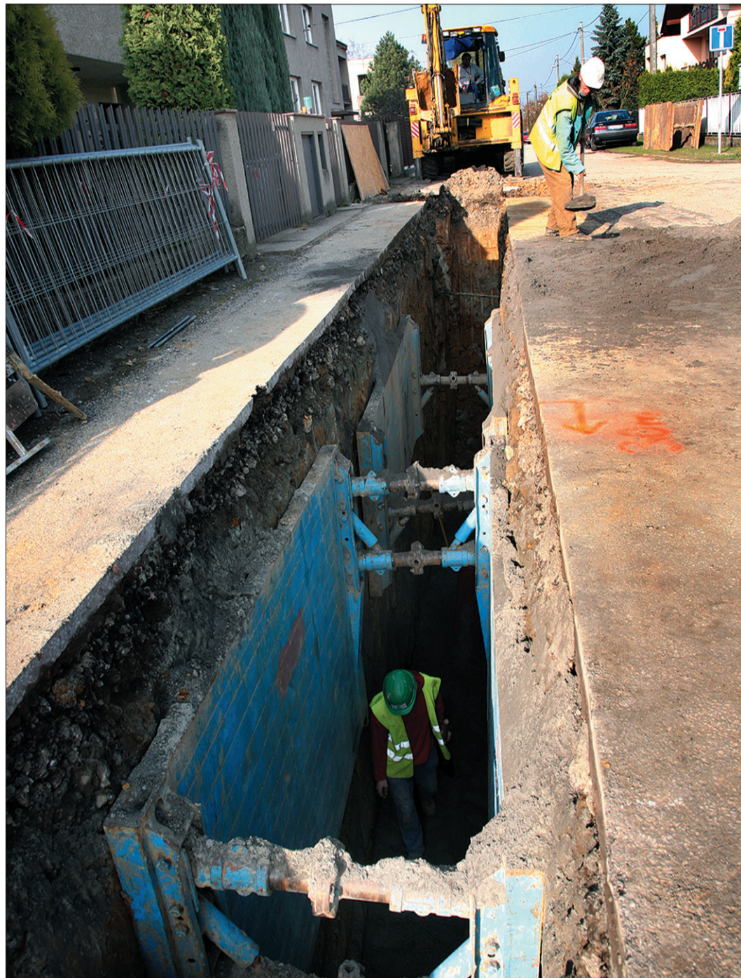
W Czeskim Cieszynie budowa kanalizacji już się rozpoczęła. W Jabłonkowie sytuacja jest gorsza. Spółka, która wygrała przetarg, kwestionuje ważność umowy i nie chce rozpocząć prac ziemnych.
