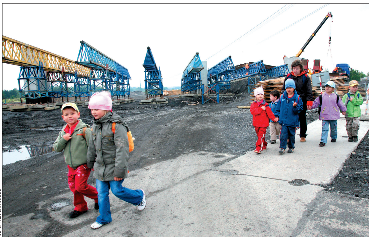
Przedшкоlaki przechodzą prowizoryczną ścieżką, łączącą Stary Bogumín z Nowym. Z obu stron rozciąga się plac budowy autostrady D47. Końca prac na razie nie widać.
