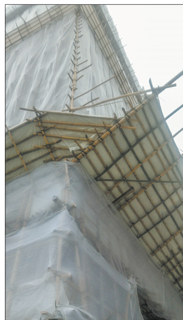
Rusztowanie z bambusa jest w Chinach rzeczą normalną.
