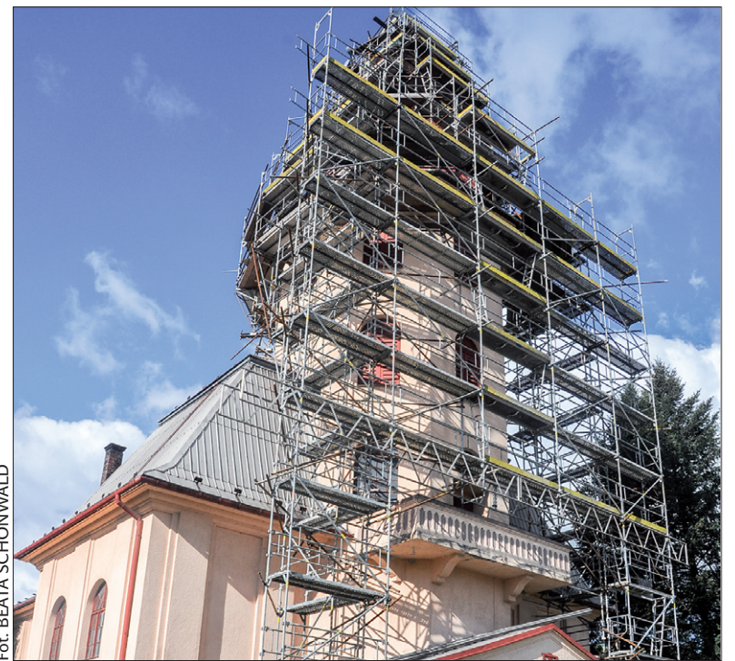
Wieża kościoła husyckiego w Rychwałdzie jest remontowana. Pierwotną więźbę dachową z 1924 roku zastąpi nowa drewniana konstrukcja.
