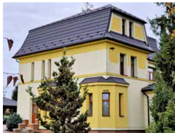
Secesyjna willa w Hołkowicach po remoncie kapitalnym
