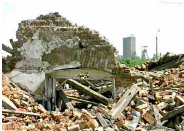
Dziesiątki domów zostało zburzonych...
