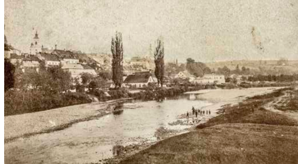
Ujęcie z mostu zalewowego na nieuregulowane koryto rzeczne wykonane przez Richarda Jastrzembkiego około 1870 r. Źródło: Zbiory prywatne autora
