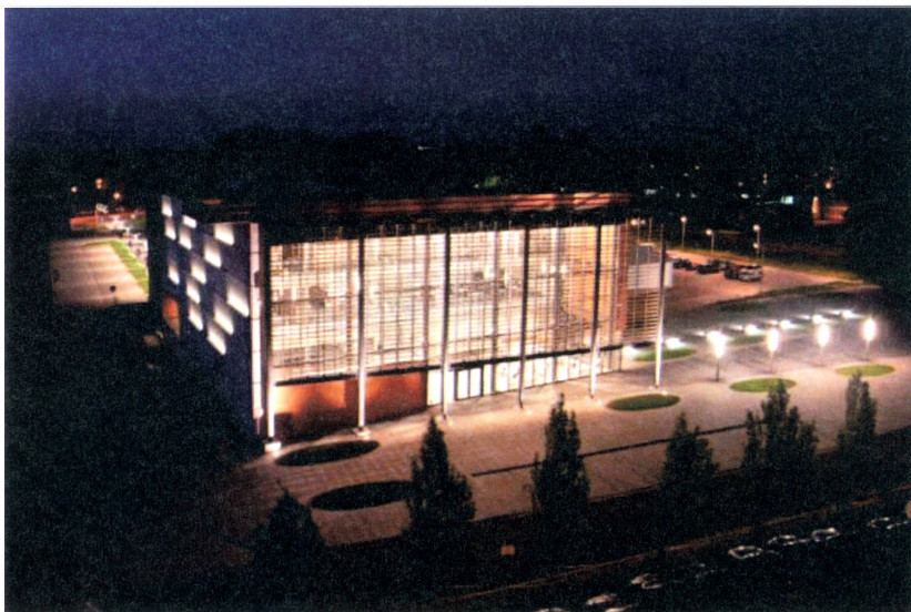
Fot. 1. Miejska Biblioteka Publiczna im. Łukasza Górnickiego Galeria Książki w Oświęcimiu
