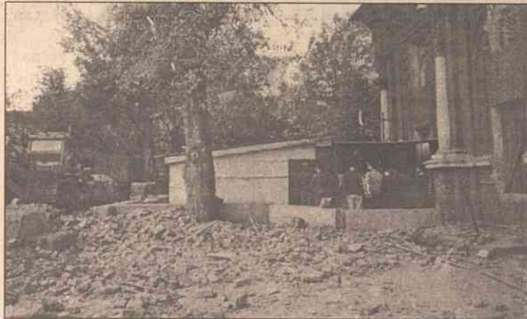
Spowiedź pod murami kościoła w garażu...
