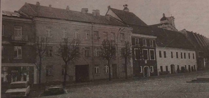
NA ZDJĘCIU: dom przy ul. Wielkiej 22.
