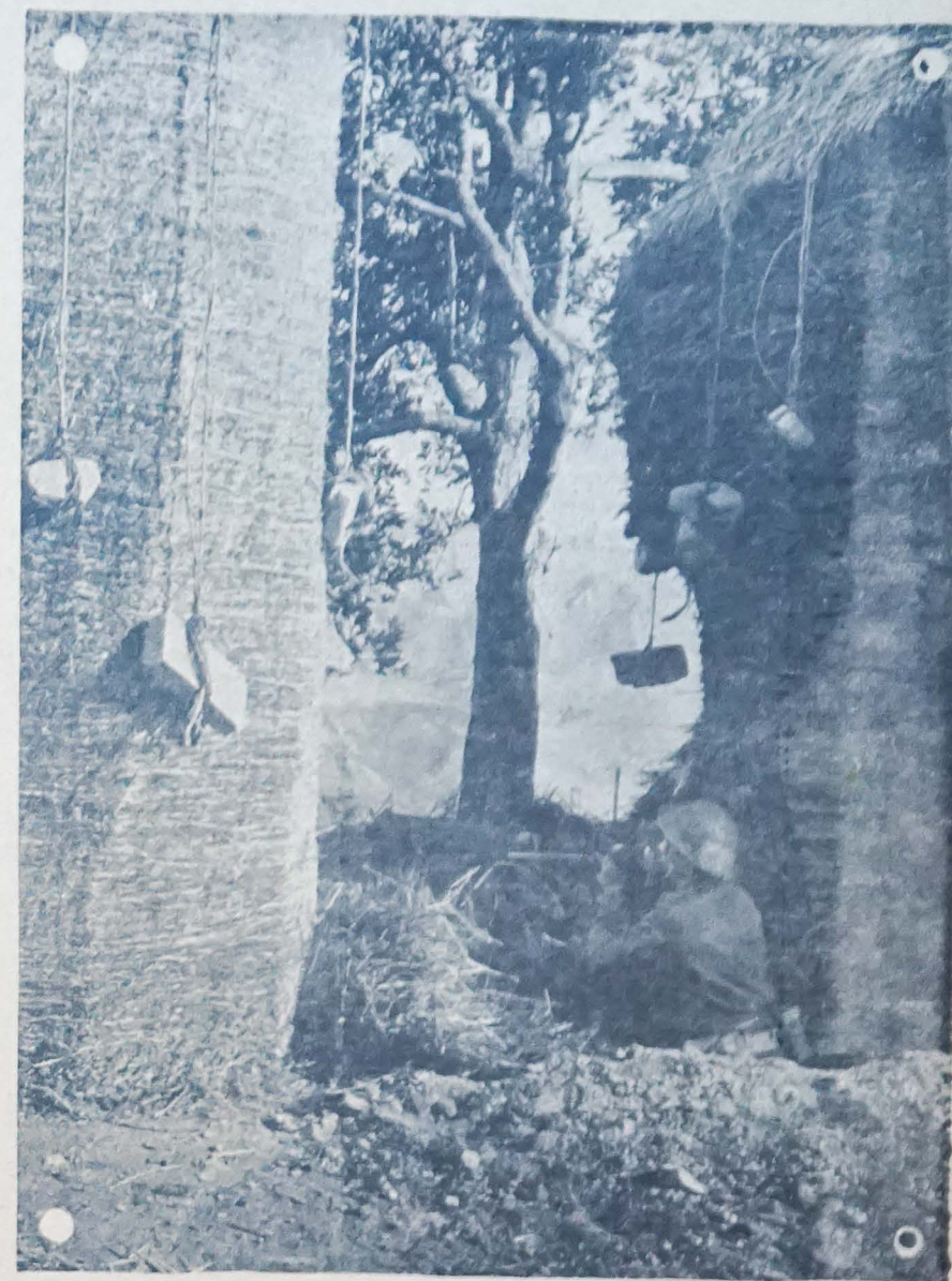
Na odcinku „Kresowej”: Ubezpieczenie (fot. Chruściel)
