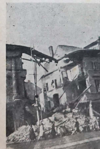
Ulica zasypana rumowiskiem
