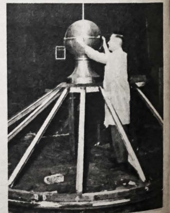
Reflektor latarni jest składany z setek soczewek, starannie dobraćych dla uzyskania jasnego i dalekosiędnego snopu światła
