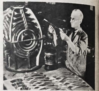
Reflektor latarni jest składany z setek soczewek, starannie dobraćych dla uzyskania jasnego i dalekosiędnego snopu światła
