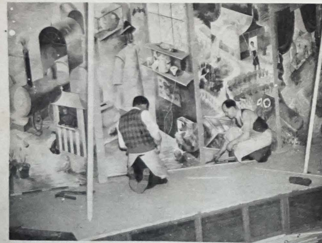
Zdjęcie wykonane podczas trwania prac przygotowawczych
