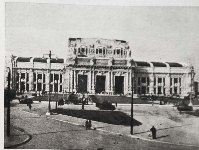
Budynek dworca kolejowego
