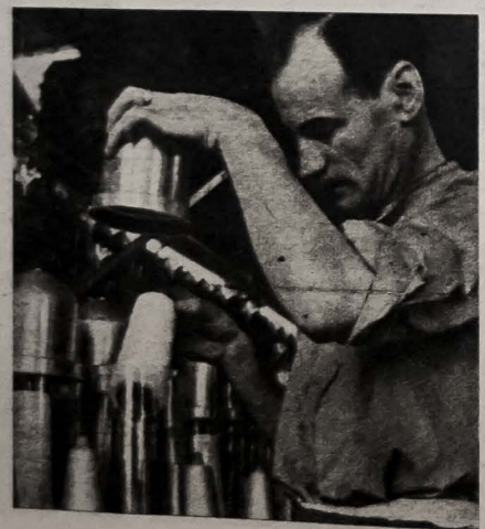
Robotnik zaktana szpulki z przędzą na maszynę trykotarską
