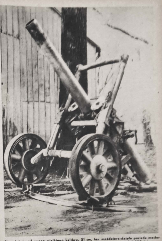
Niezależnie od swego wielkiego kalibru, 21 cm, ten moździerz-działo posiada mechanicznym zamkiem i urządzenie powrotne. Ciężar moździerza — ponad 2,500 kg
