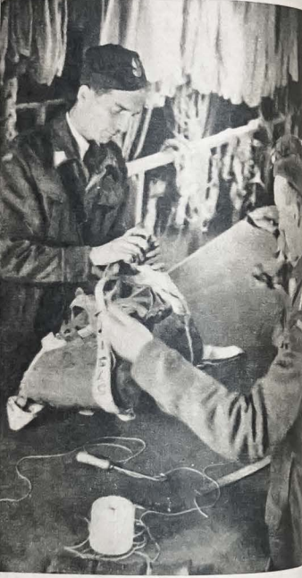
Kontrola i naprawa płacht spadochronowych. Checking and repairing parachutes.
