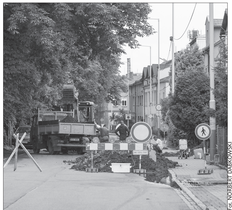
Do 25 lipca należy się liczyć w Cz. Cieszynie z zamknięciem odcinka o długości 30 metrów przy ul. Fabrycznej. Powodem są prace budowlane w zakresie sieci inżynierskich oraz naprawa łącznicy kanalizacyjnej. Objazd prowadzi po ul. Strzelniczej, Dukielskiej i Nad Potokiem. Autobusy kursować będą zgodnie z rozkładem jazdy. (maki)
