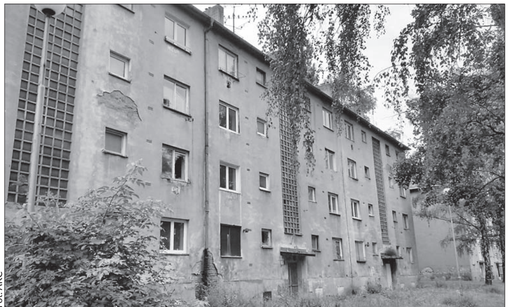
Na wyburzenie tego domu miasto ma już pieniądze.
