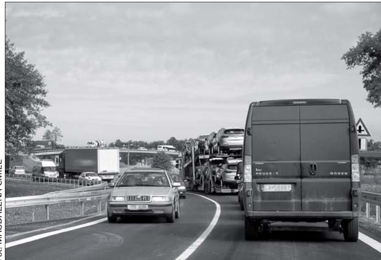
Fot. MAGDALENA CMIEL Wczoraj został otwarty nowy odcinek wiodący wzdłuż drogi I/11.
