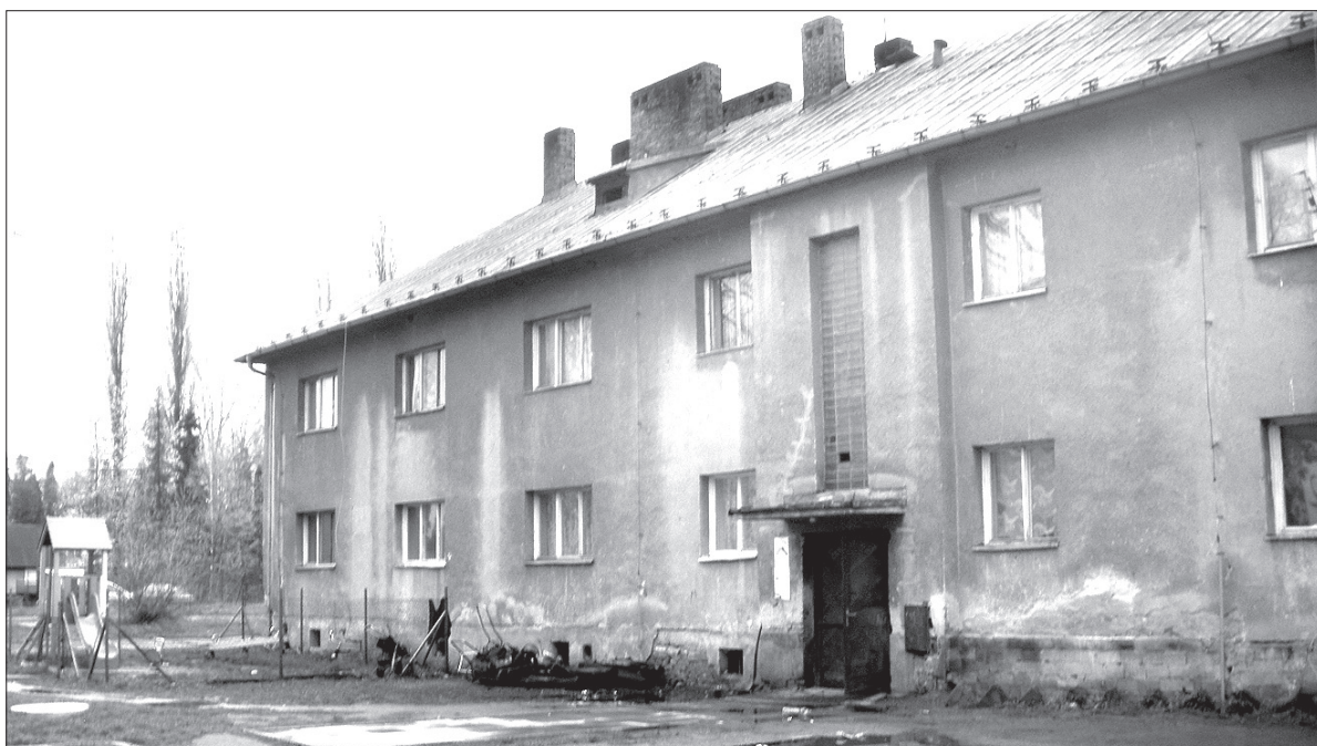
Budynki, nad kupnem których zastanawiali się radni, prezentują się nieciekawie.
