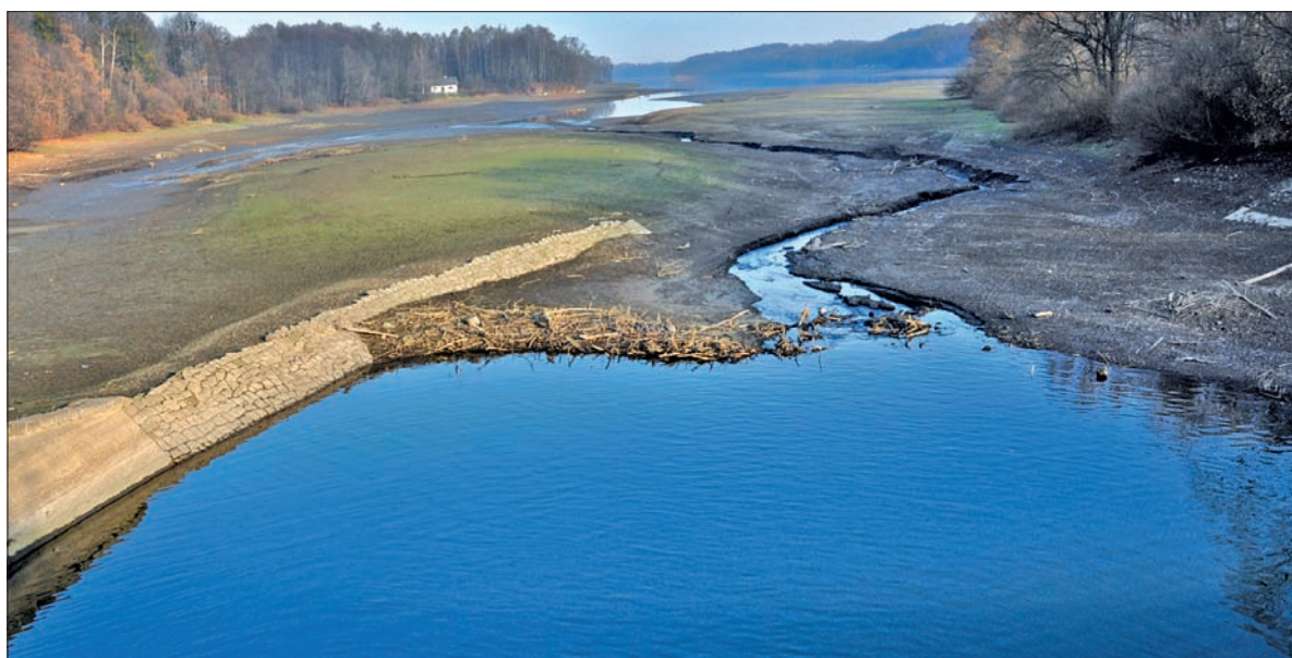
Odsłonięte dno Zbiornika Cierlickiego – widok od strony malej tamy w Cierlicku.
