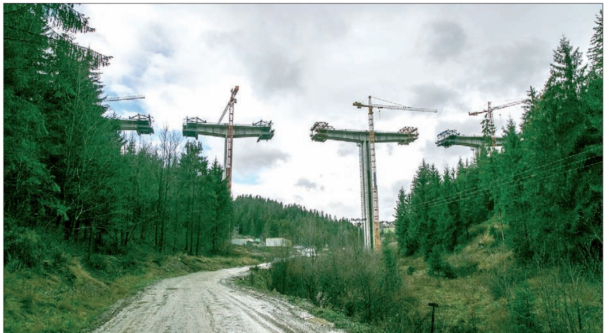
Valy będą najwyższym mostem autostradowym na Słowacji.
