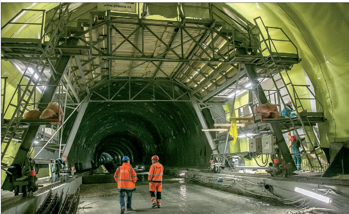
W tunelu Polana praca wre.
