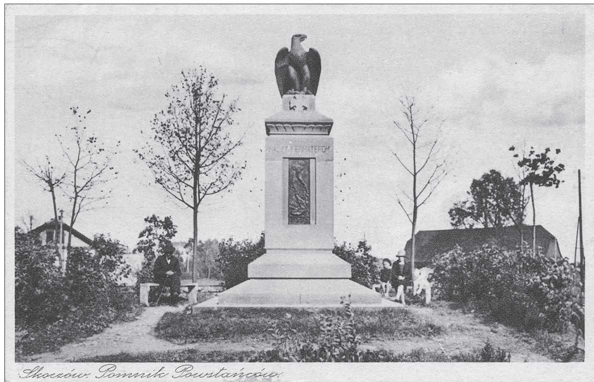
Zastąpi go replika przedwojennego monumentu.
