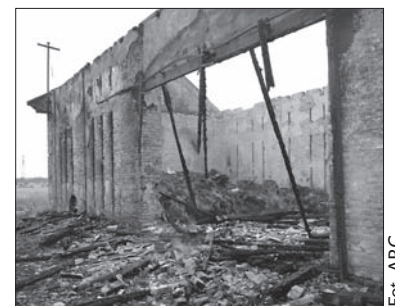
Z obiektu pozostały jedynie zglisty.
