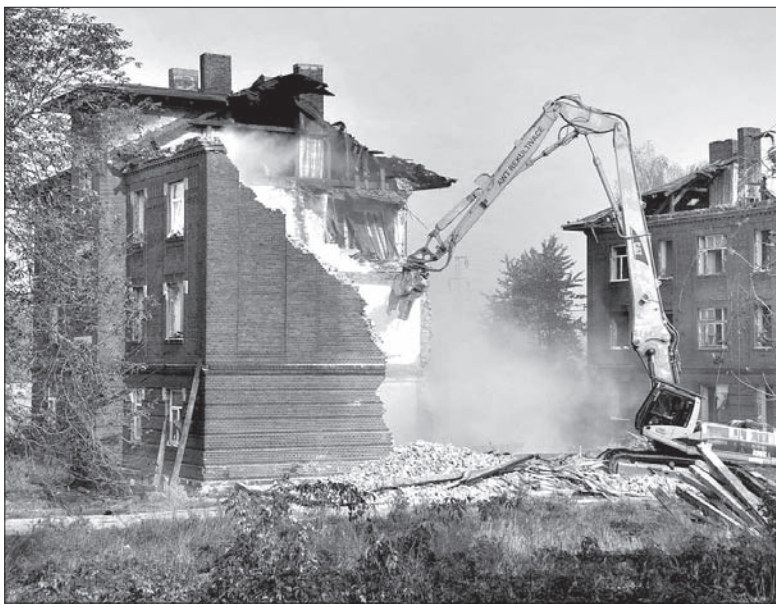
Pierwszy budynek zrównano z ziemią wiosną, teraz przyszła pora na kolejne.
