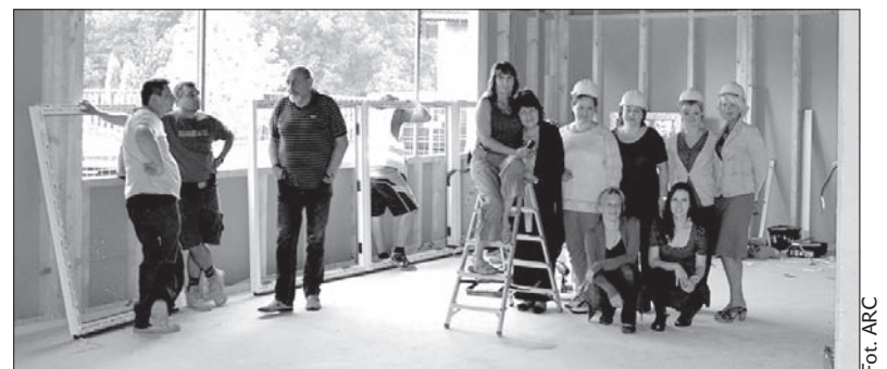
Na terenie budowy.
