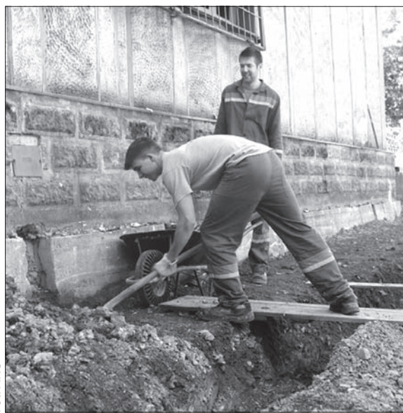
Prace remontowe w letnim kinie w Orłowej dobiegają końca.
