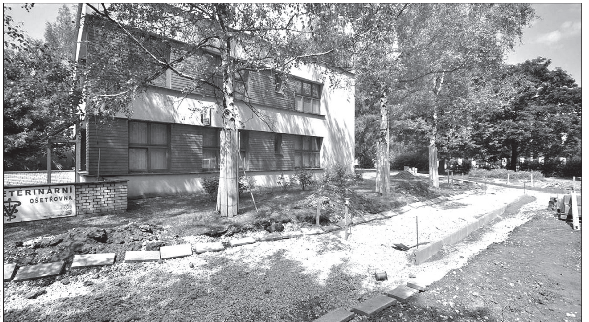
W centrum Bogumina trwają intensywne prace budowlane. Na zdjęciu odcinek prac za przychodnią weterynaryjną.
