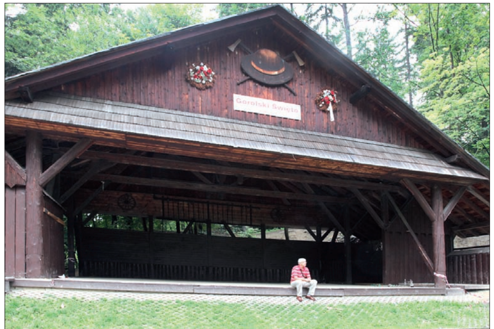
Dach nad sceną wybudowano w latach 80. XX w.
