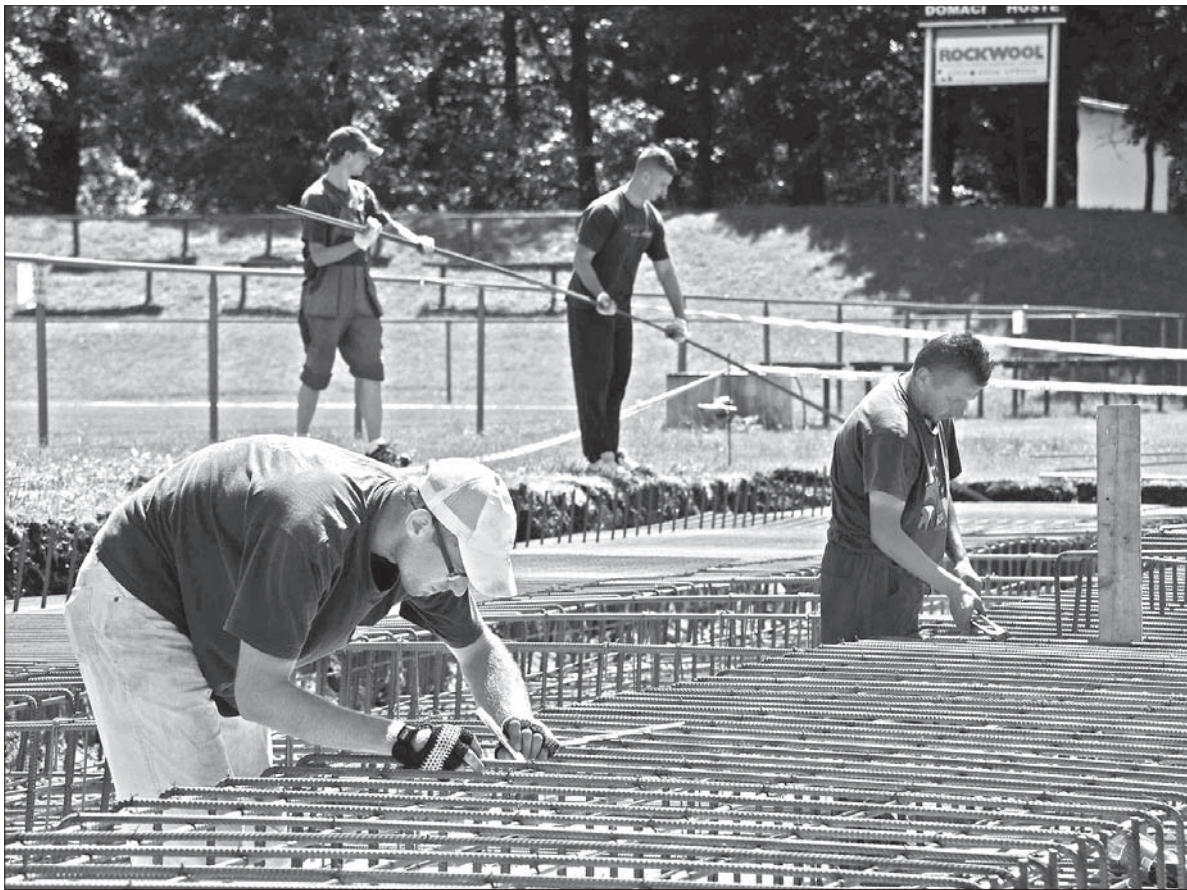
Zbrojenie płyty nowej trybuny w Boguminie.
