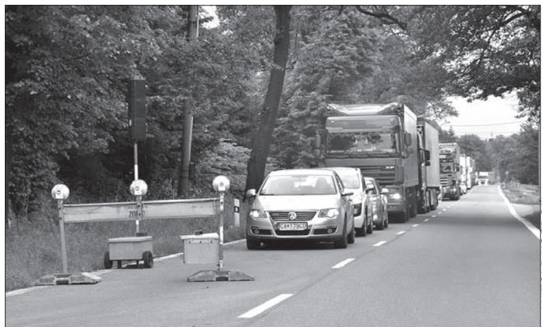
Na odcinku drogi w okolicach mostu w Ropic obowiązuje ruch jednostronny kierowany sygnalizacją świetlną.
