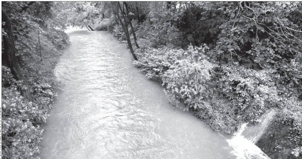
Wysoki poziom wody na Stonawce w Olbrachcicach.
