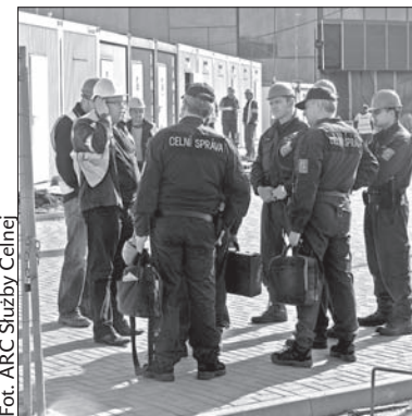
Kontrola na placu budowy.
