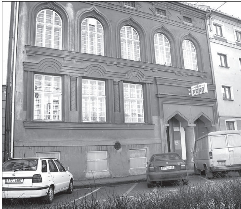
W budynku dawnej synagogi przy ulicy Bożka w najbliższych dniach ruszą prace budowlane.
