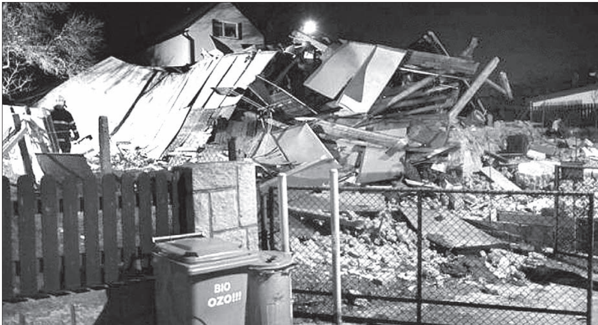
Po wybuchu z budynku pozostały gruzy.
