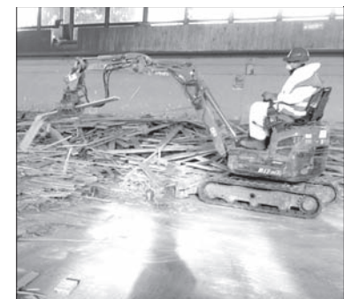
Remont w hali sportowej.
