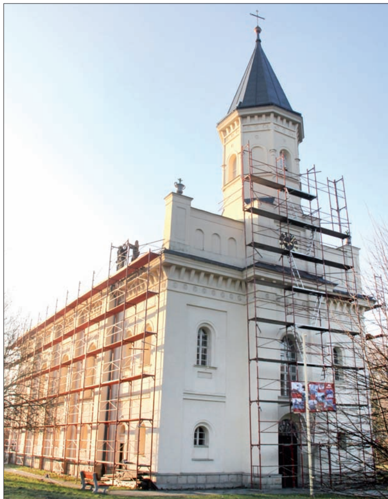
W tym tygodniu dobiegał końca remont dachu i wieży kościoła.
