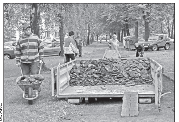
Prace remontowe w Czeskim Cieszynie.
