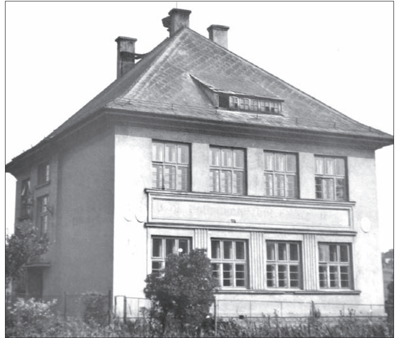
Budynek w Cierlicku Dolnym, w którym uczyły się polskie dzieci, zburzony z powodu powstającego zalewu.
