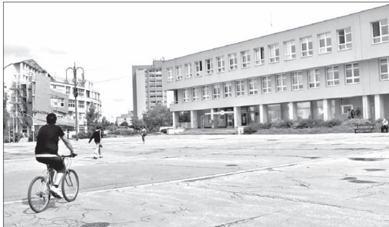
Popękany beton i pusta przestrzeń. Tak wygląda centralny plac w Orłowej-Lutyni.
